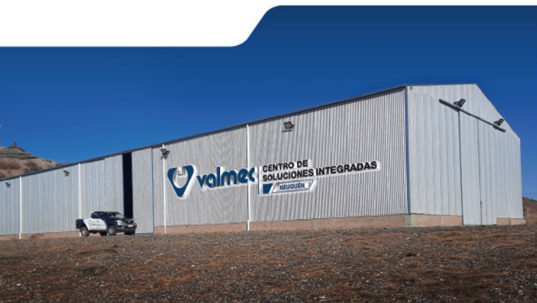
VISTA DEL CENTRO DE SOLUCIONES INTEGRADAS NEUQUEN, ARGENTINA VIEW OF THE INTEGRATED SOLUTIONS CENTER NEUQUEN, ARGENTINA
